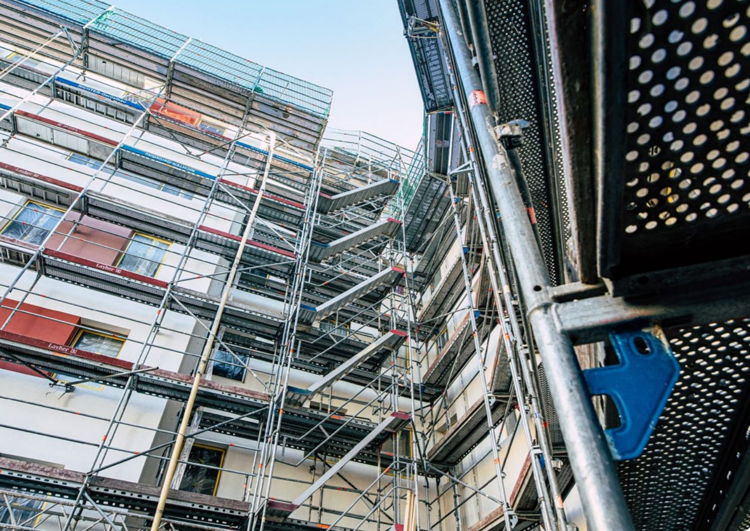
Geduldprobe: Das Gerüst im Innenhof ist kein Blickfang, ermöglicht aber ein sicheres Arbeiten.
